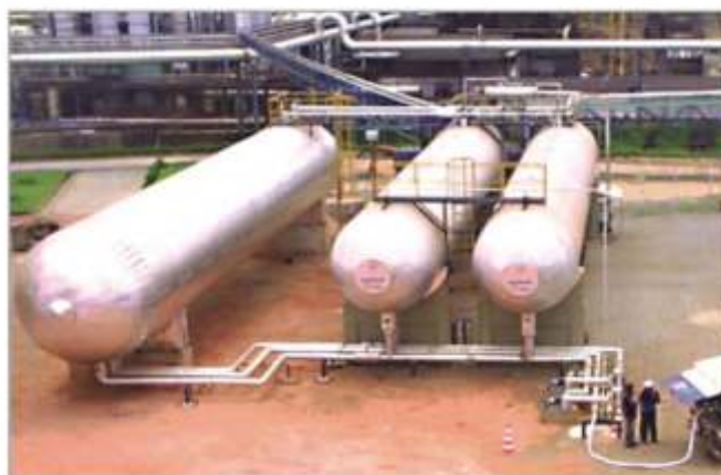
Tanque de 250 ton. fabricado com chapas de aço carbono
