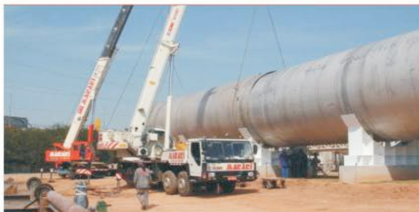
Tanque interno em fabricação
