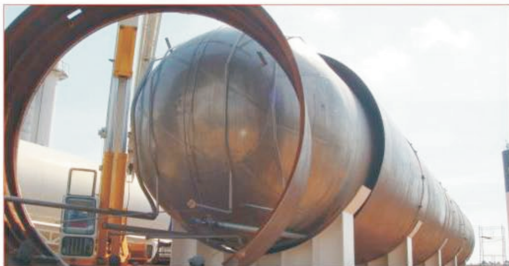
Operação de encamisamento do tanque
